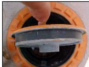
Spill bucket lid gasket
